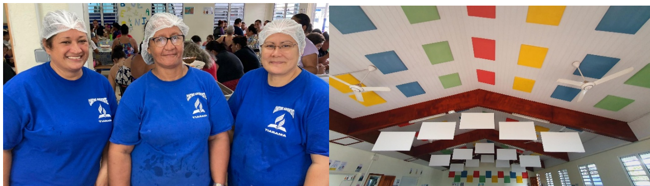
Amélioration de l'acoustique de la cantine TIARAMA (livré 2022)
